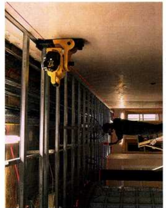
4. Vorbereitungen für das Anbringen der Decklage
