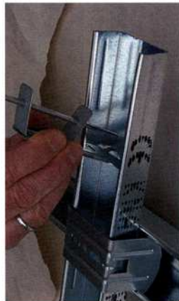
2. Kreuzverbinder fixieren Grund- und Tragprofile, Einsetzen eines Anker-Schnellspannabhängers
