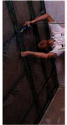
9. Holzlatte werden mit Direktabhängern befestigt
